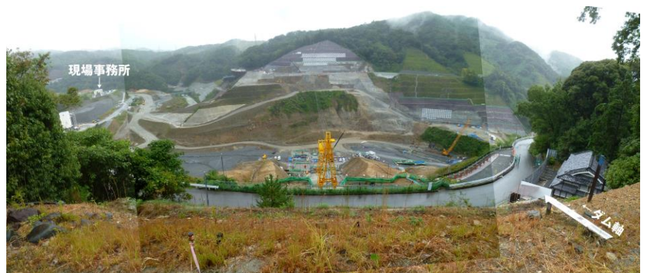
ダム本体の中心部(黄色の櫓)付近の工事状況
